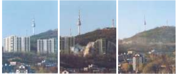
Demolisi Apartemen Dalam Rangka Penataan Penghalang Pandang Visual Puncak Gunung Namsan
