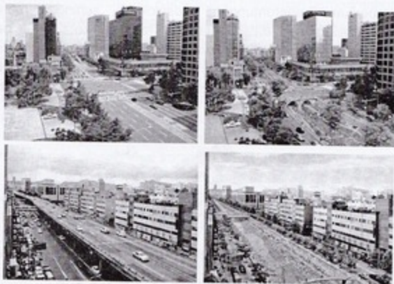
Gambar 9. Sungai Cheonggyecheon, sebelum (kiri) dan sesudah (kanan) restorasi
